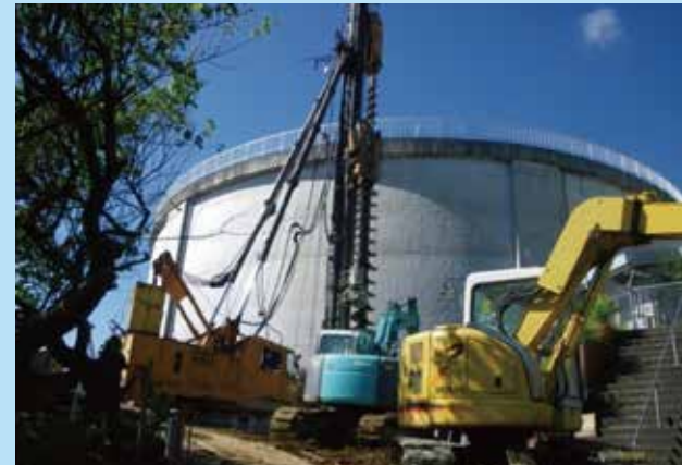
中河原1号配水池の杭の増設による耐震補強
